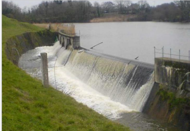
Déversoirs en rive droite (évacuateur de crues)
